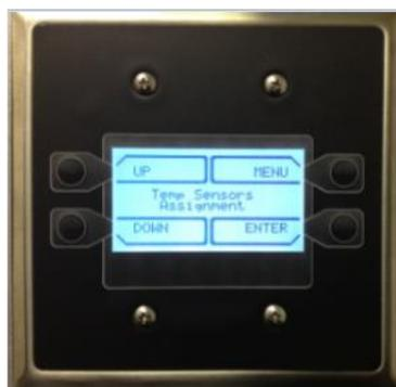
Le tableau ECPM03 permet à l'utilisateur de surveiller le système et de configurer un large choix d'options associées à la fonctionnalité du système. Le suivi est effectué via les menus de configuration sur l'écran LCD de l'ECPM03 comme indiqué ci-dessus. La configuration est effectuée sur l'IHM après avoir requis la Configuration à travers le menu de l'ECPM03.
